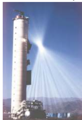
Fig. 2 - Instalația CESA1 - Turnul receptor
