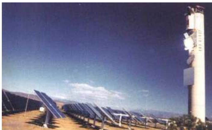
Fig. 1 - Platforma Solară Almeria - Instalația CESA1
